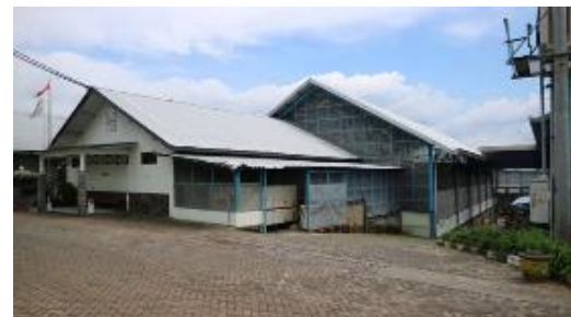
(d) Lanskap A14 (Area Pabrik)
