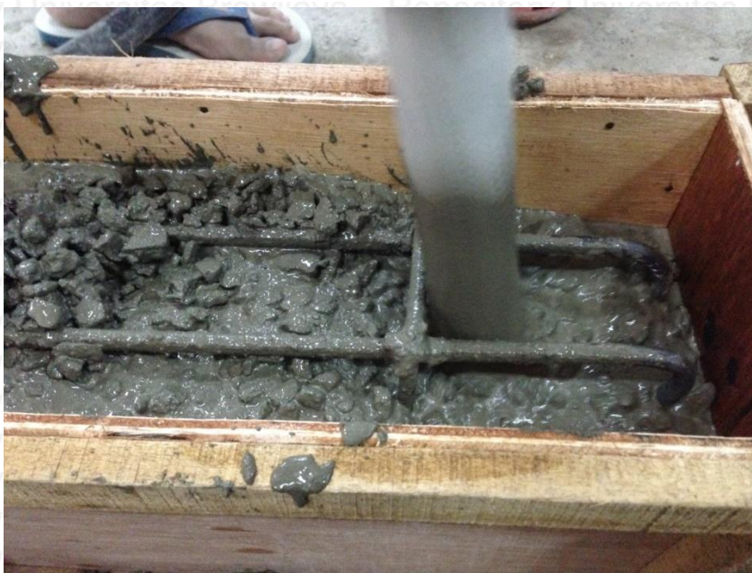
Gambar 4. Pemadatan dengan Vibrator
