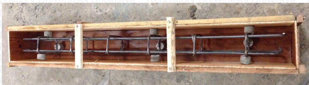
Gambar 2. Bekisting Balok
