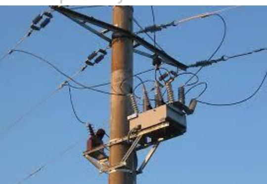
Gambar 2.16 Bentuk fisik recloser dan penempatan Recloser pada jaringan distribusi PT. PLN
