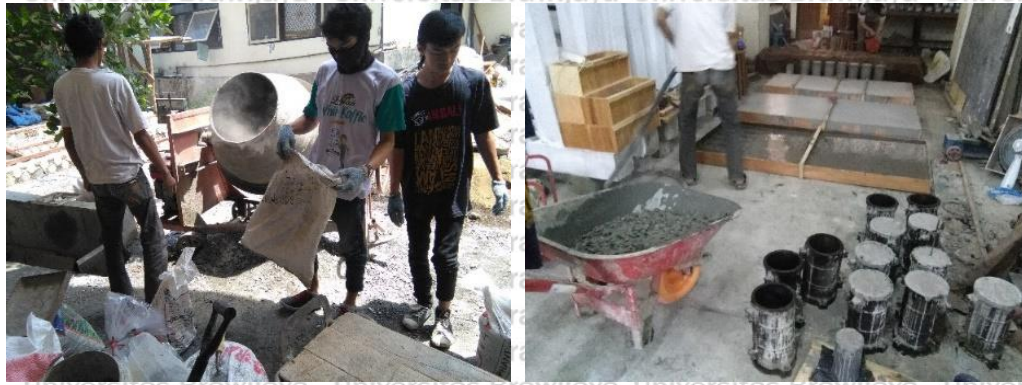
Gambar 5.33 Pengecoran benda uji pelat
