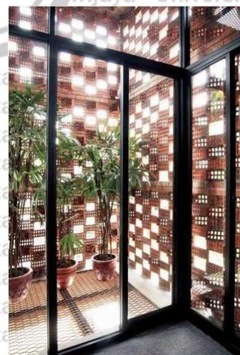
Gambar 2.15 Penerapan Roster pada Dinding Eksterior
