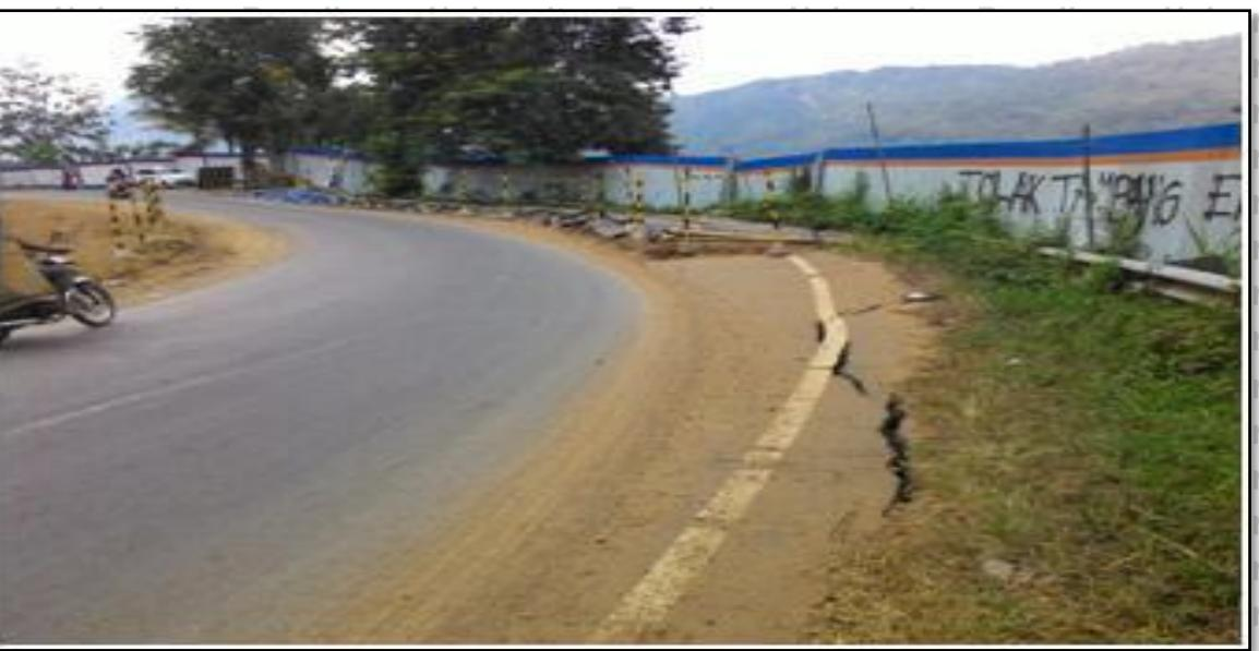
Gambar 3.2. Kondisi Jalan Pada Cross STA 0+125 yang Sudah Terjadi Keretakan
