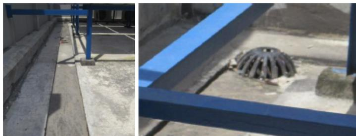
Gambar 4.40 Jalur air hujan dan lubang menuju pipa air hujan pada rooftop
