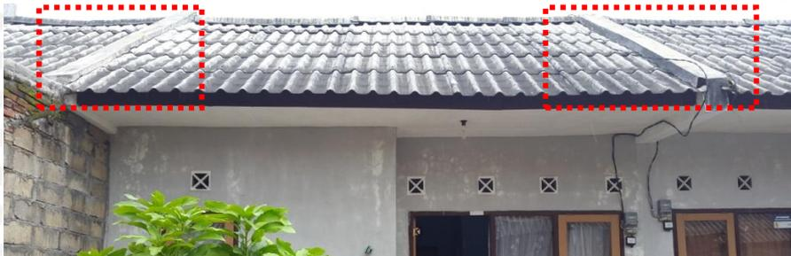
**Gambar 4.29** Sambungan atap antar rumah yang sering rembes
