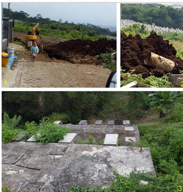
**Gambar 4.19** (1) Pengerjaan saluran septictank umum, (2) pipa septictank umum, (3) septictank
