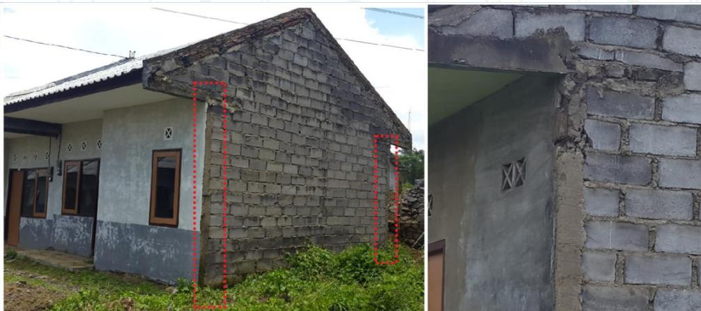
**Gambar 4.25** Kolom rumah tipe 36 (kiri) Kolom yang tidak maksimal (kanan)
