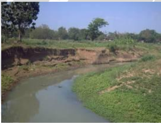
Foto9. Kondisi Tebing Kali Mungkung pada CP127
