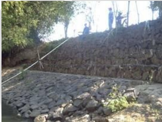
Foto15. Bronjong Kali Mungkung pada CP44
