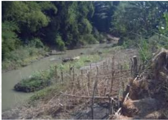
Foto13. Kondisi Tebing Kali Mungkung pada CP104
