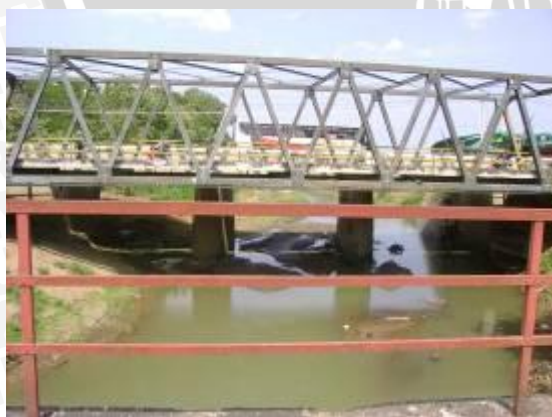
Foto 5. Jembatan pada CP 134
