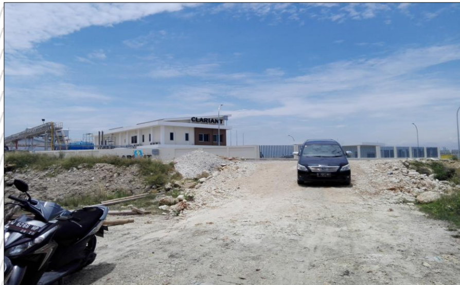
Gambar 2.2 Proses Pembangunan Pabrik PT. Clariant
