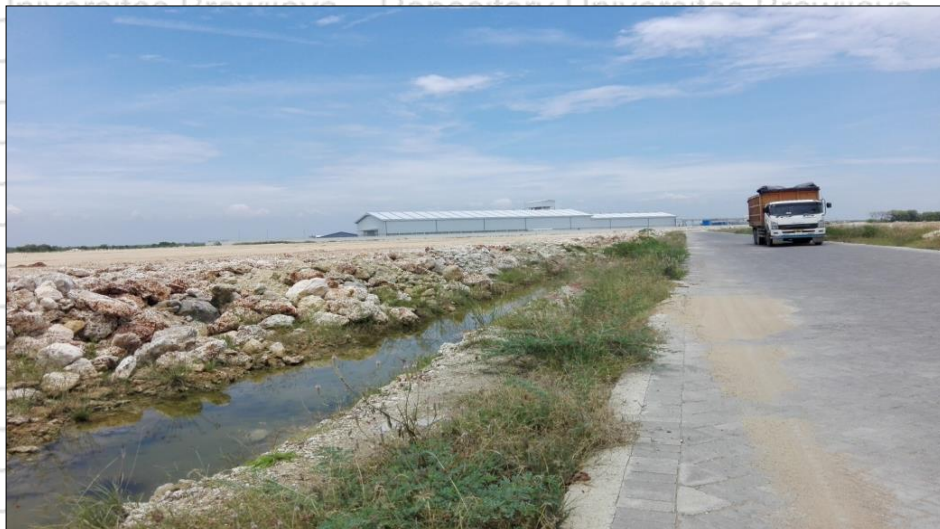
Gambar 3.1 Proses Pengurukan Lahan Tambak untuk Digunakan Sebagai Jalan Utama Menuju Pelabuhan (Sumber : Dokumentasi Pribadi)
