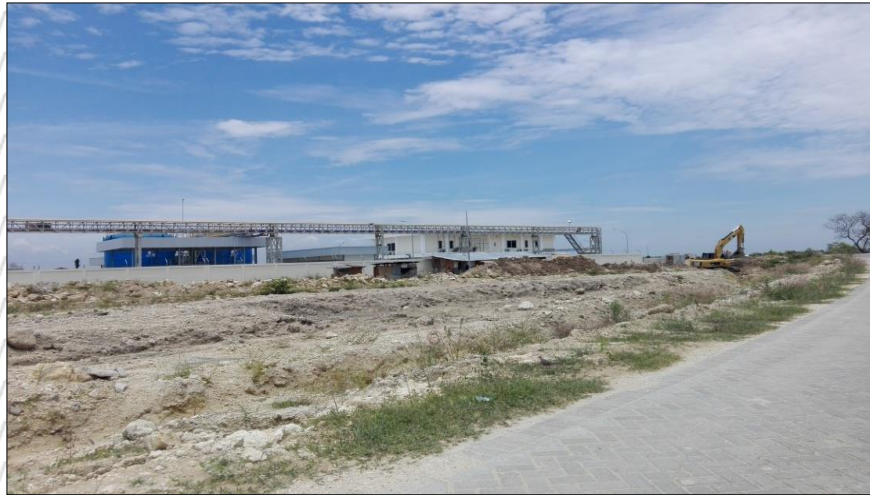
Gambar 2.3 Proses Pembangunan Industri Pabrik di Wilayah JIPE
