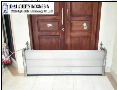
Gambar 2. 7 Pemasangan pintu penahan air Sumber: Pangestu, 2008
