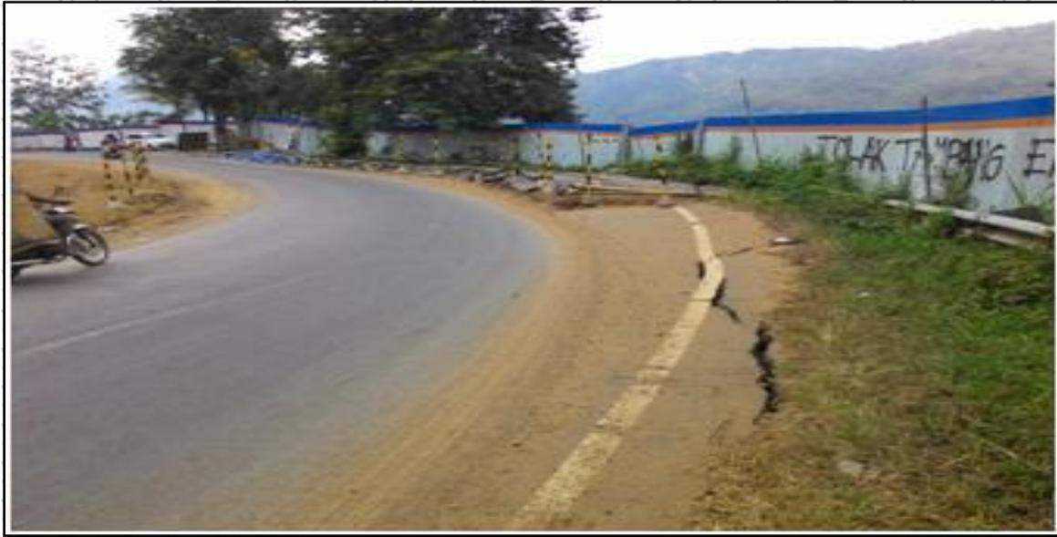
Gambar 3.2. Kondisi Jalan Pada Cross STA 0+125 yang Sudah Terjadi Keretakan
