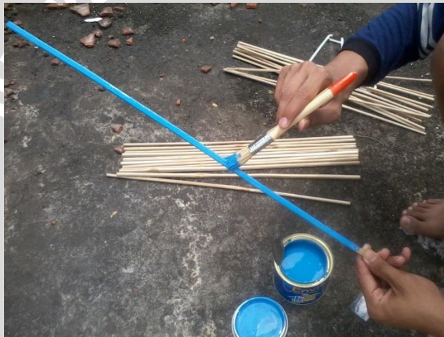
Pelapisan Tulangan Bambu dengan Cat
