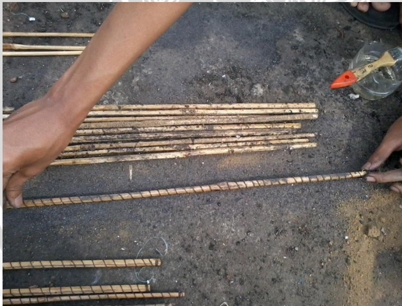
Gambar L.2 Pemberian lapisan pasir pada tulangan bambu
