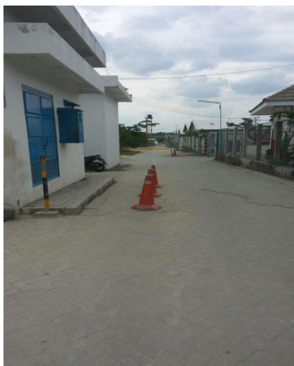
Gambar 4. Kondisi Jalan di Pabrik Sumber : Data Primer Hasil Observasi Peneliti 2017
