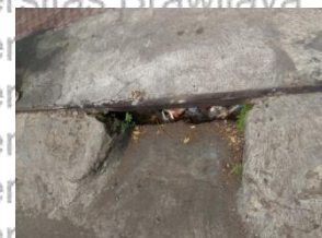
(saluran drainase tertutup)
