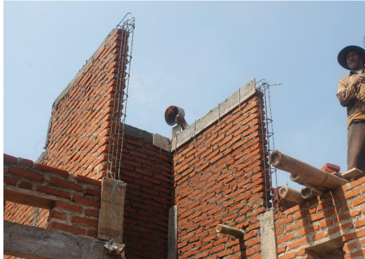
Gambar 4.27 Pemasangan dinding diikuti cor kolom praktis pada survei 3
