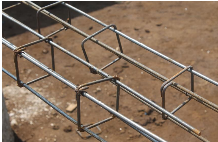
Gambar 4.26 Detail sengkang pada survei 3
