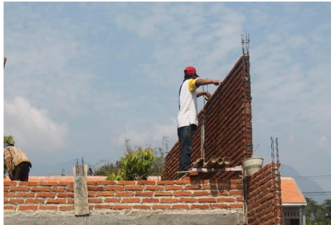
Gambar 4.22 Mortar pasangan dinding bata pada survei 3
