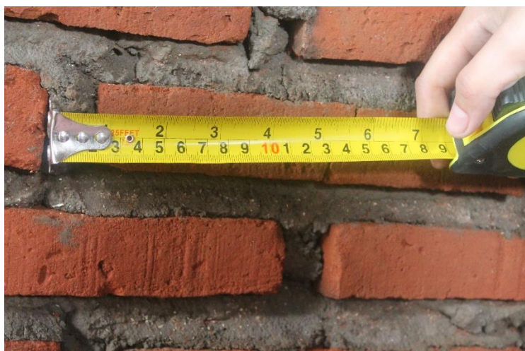
Gambar 4.32 Spesi pasangan dinding bata pada survei 4
