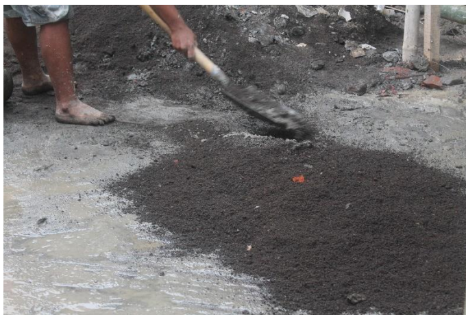
Gambar 4.31 Mortar pasangan dinding bata pada survei 4
