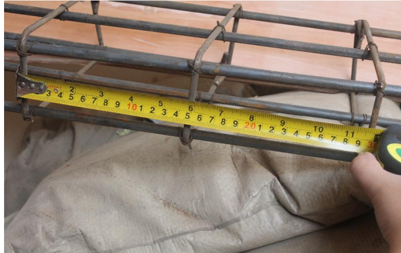
Gambar 4.35 Detail sengkang pada survei 4
