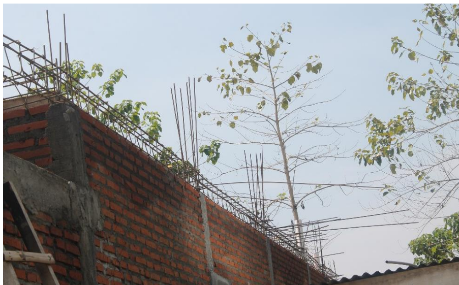
Gambar 4.16 Sambungan balok dengan kolom pada survei 2
