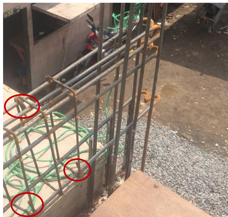
Gambar 4.8 Detail sengkang pada survei 1
