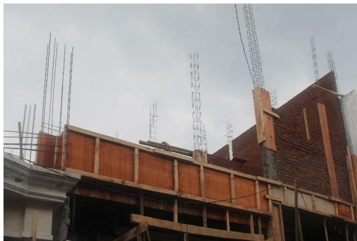
Gambar 4.34 Sambungan balok dengan kolom pada survei 4
