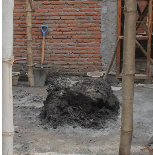
Gambar 4.13 Mortar pasangan dinding bata pada survei 2
