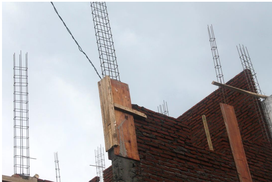
Gambar 4.36 Pemasangan dinding diikuti cor kolom praktis survei 4
