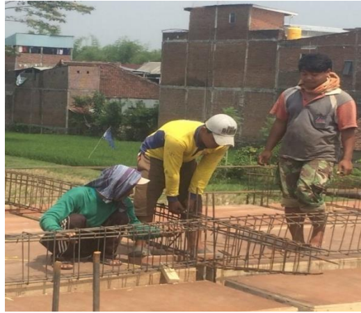
Gambar 4.7 Sambungan balok dengan kolom pada survei 1
