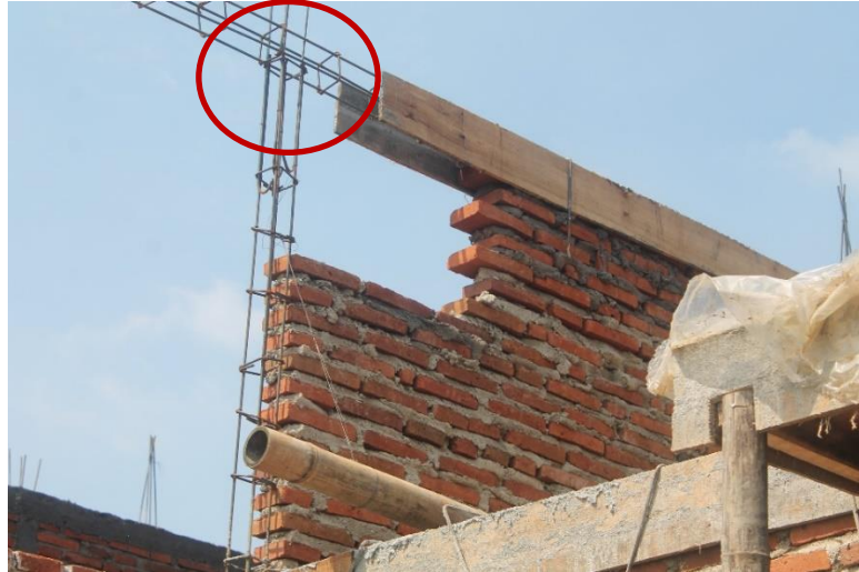
Gambar 4.25 Sambungan balok dengan kolom pada survei 3
