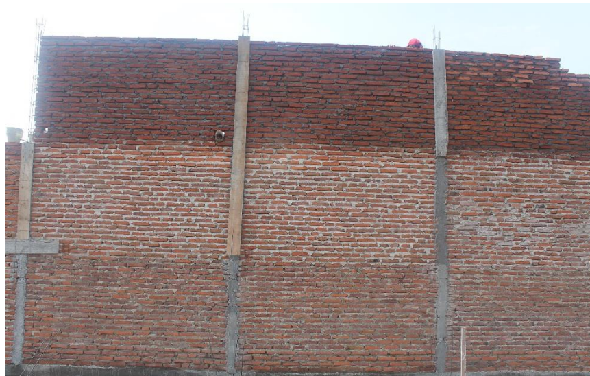
Gambar 4.24 Kolom praktis pada survei 3
