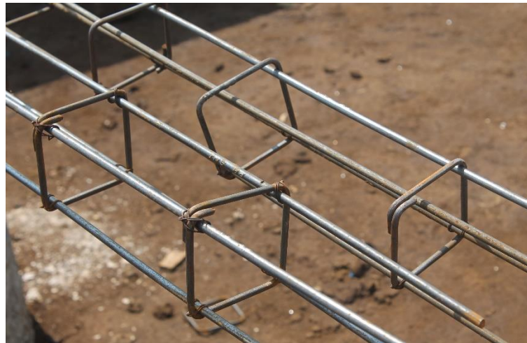
Gambar 4.26 Detail sengkang pada survei 3
