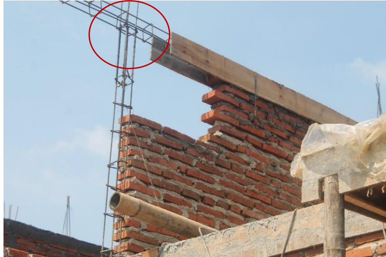
Gambar 4.25 Sambungan balok dengan kolom pada survei 3
