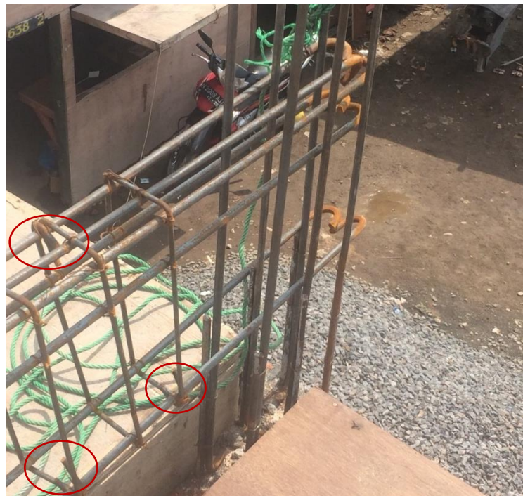
Gambar 4.8 Detail sengkang pada survei 1
