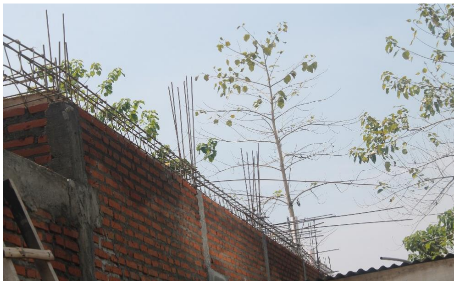
Gambar 4.16 Sambungan balok dengan kolom pada survei 2
