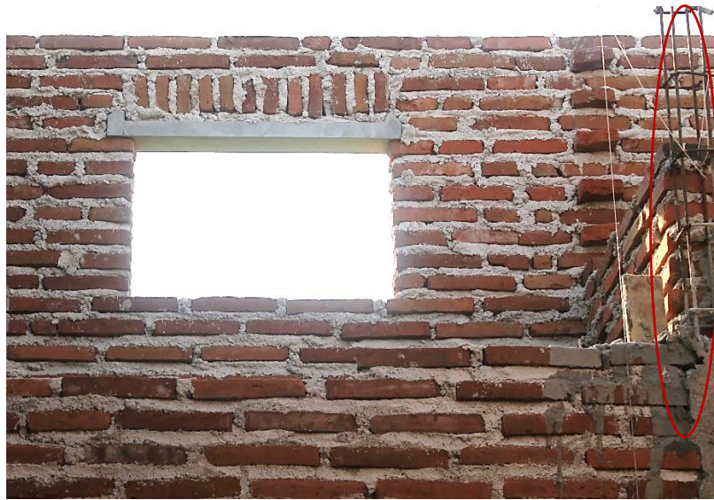
Gambar 4.6 Kolom praktis pada survei 1
