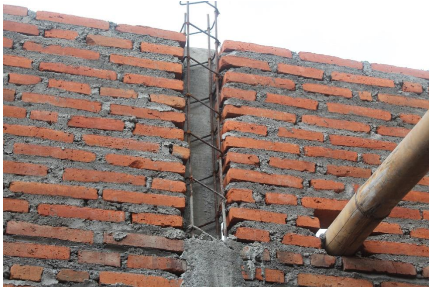
Gambar 4.17 Pemasangan dinding bata diikuti cor kolom praktis pada survei 2
