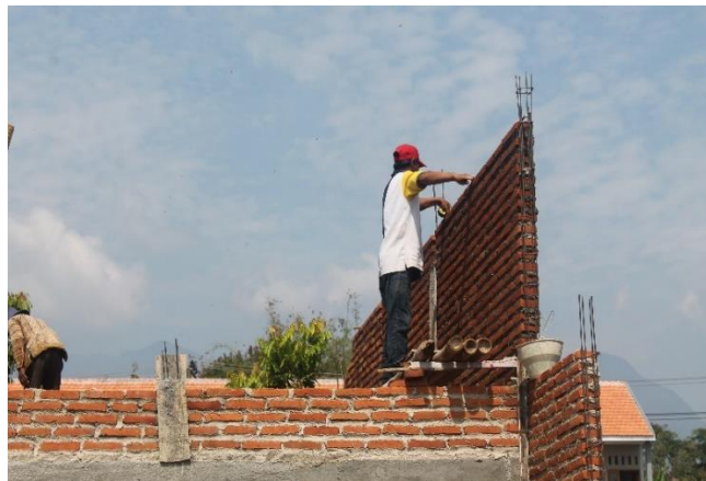
Gambar 4.22 Mortar pasangan dinding bata pada survei 3
