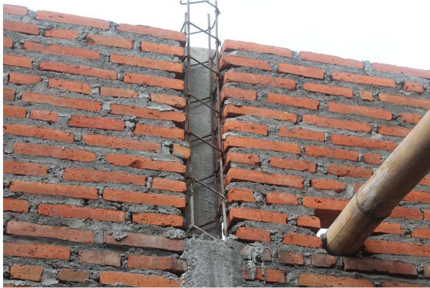
Gambar 4.15 Kolom praktis pada survei 2
