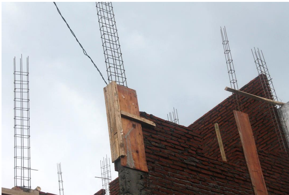
Gambar 4.36 Pemasangan dinding diikuti cor kolom praktis survei 4
