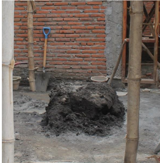
Gambar 4.13 Mortar pasangan dinding bata pada survei 2
