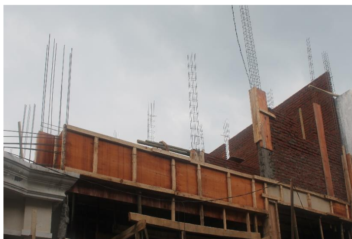
Gambar 4.34 Sambungan balok dengan kolom pada survei 4
