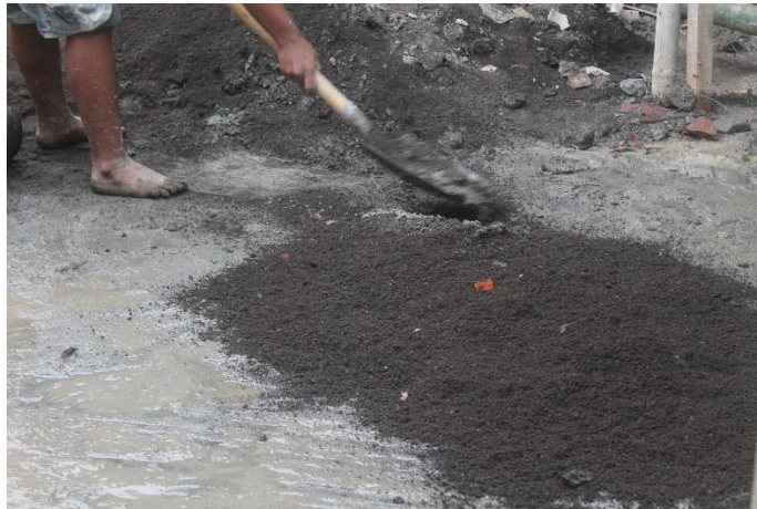
Gambar 4.31 Mortar pasangan dinding bata pada survei 4
