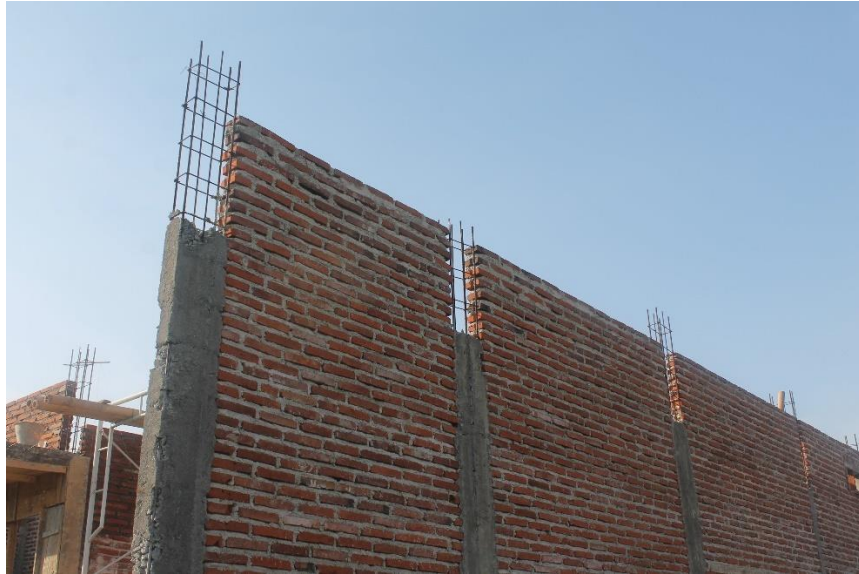
Gambar 4.9 Pemasangan dinding bata diikuti cor kolom praktis pada survei 1
