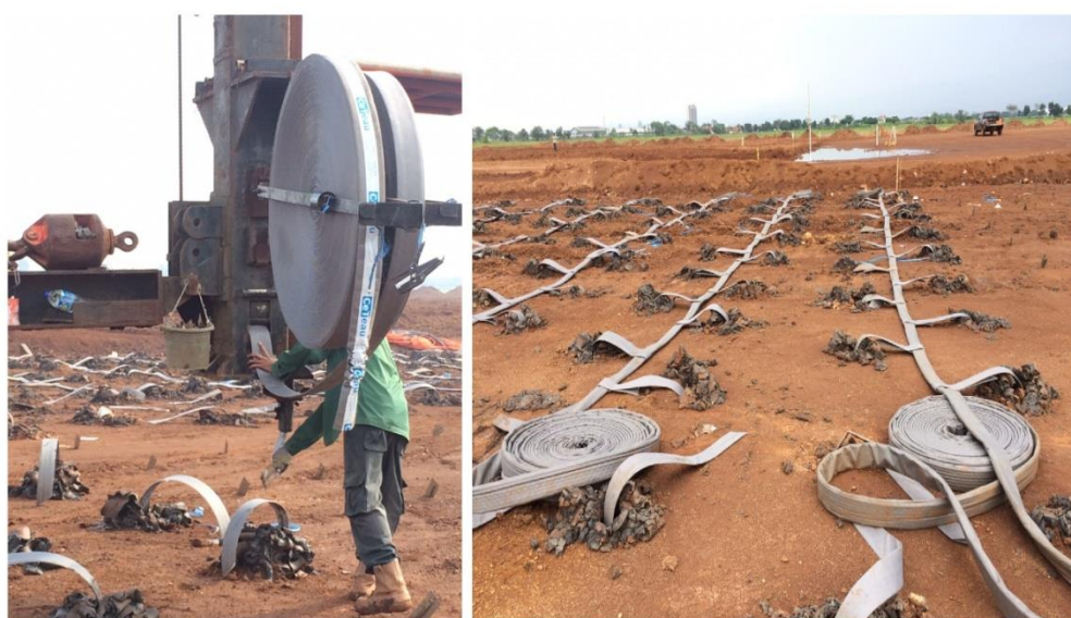
Gambar 4.3 Pemasangan vertical drains
