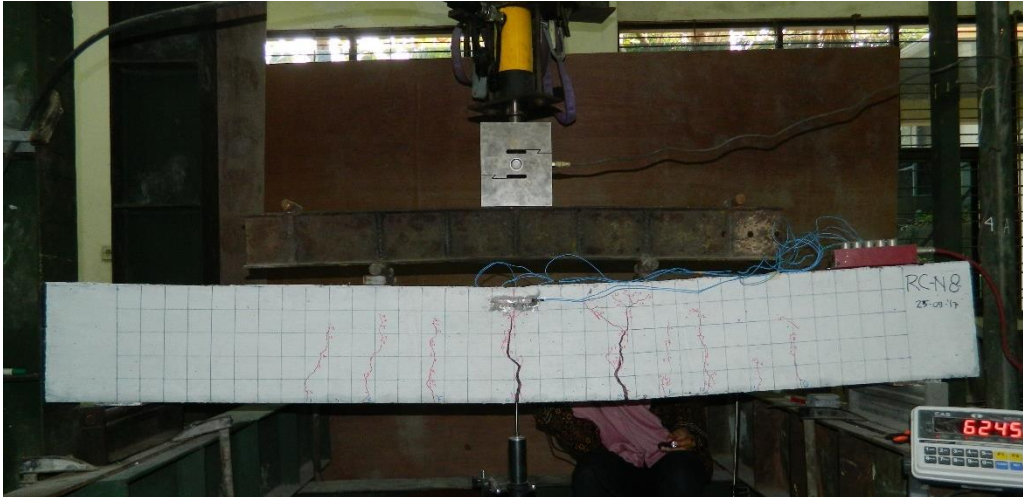
Gambar 4.5 Pengamatan lebar retak RC-N8
