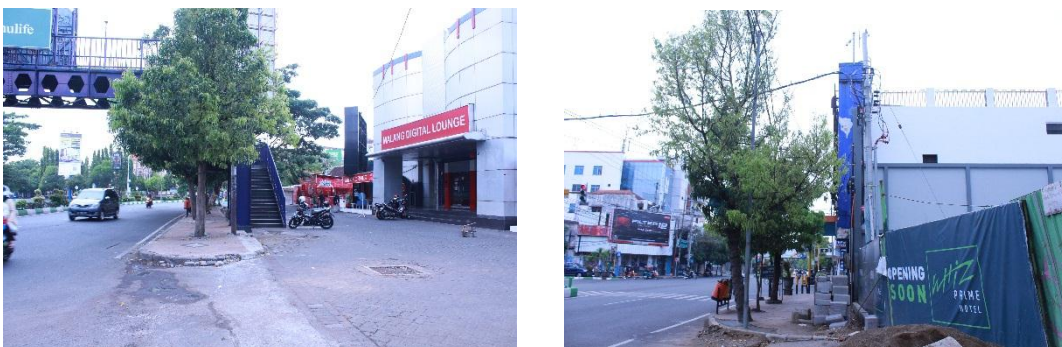
Gambar 4. 3 Kondisi Penyebrangan Pada Koridor Jalan Kayutangan
