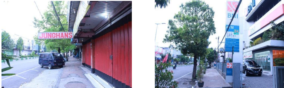
Gambar 4. 8 Kondisi Eksisting Signage Jalur 1
