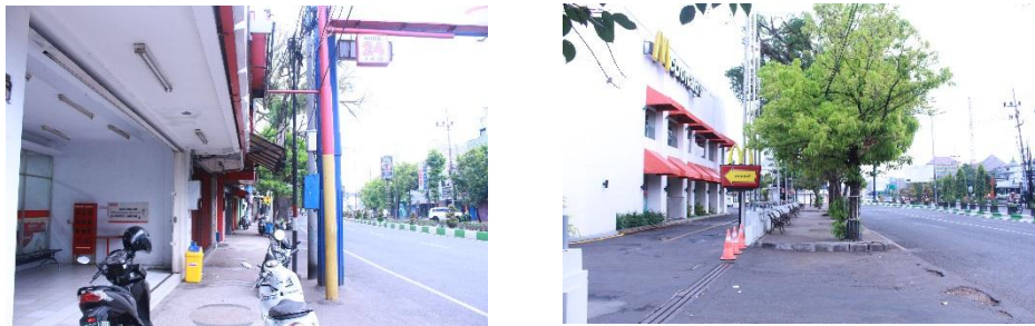
Gambar 4. 9 Kondisi Eksisting Signage Jalur 2
