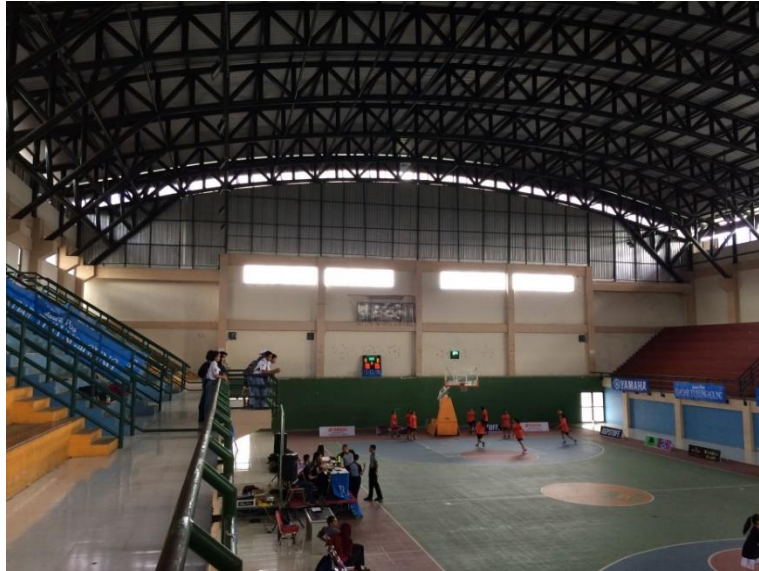
Gambar 4.31 Eksisting Atap Bangunan GOR Sumber : Dokumentasi Pribadi
