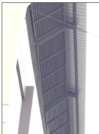
Gambar 4.33 Bukaan jalousie Pada Bangunan Sumber : dokumentasi pribadi
