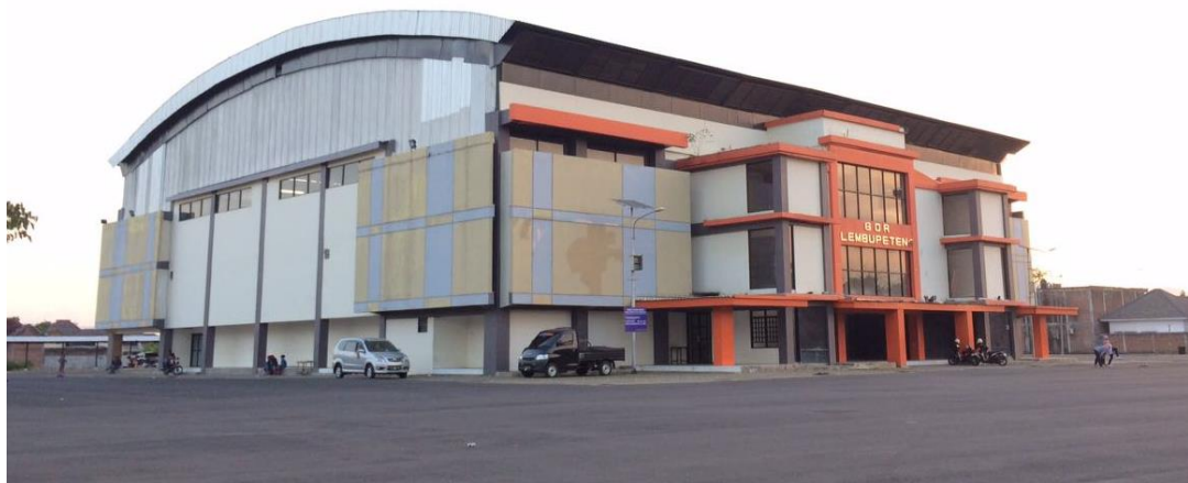
Gambar 4.24 Kondisi Eksisting Bangunan GOR Sumber : Dokumentasi Pribadi
