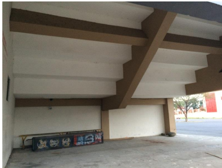
Gambar 4.28 Ruang Kosong di Bawah Tribun Bagian Belakang Bangunan GOR Sumber : Dokumentasi Pribadi
