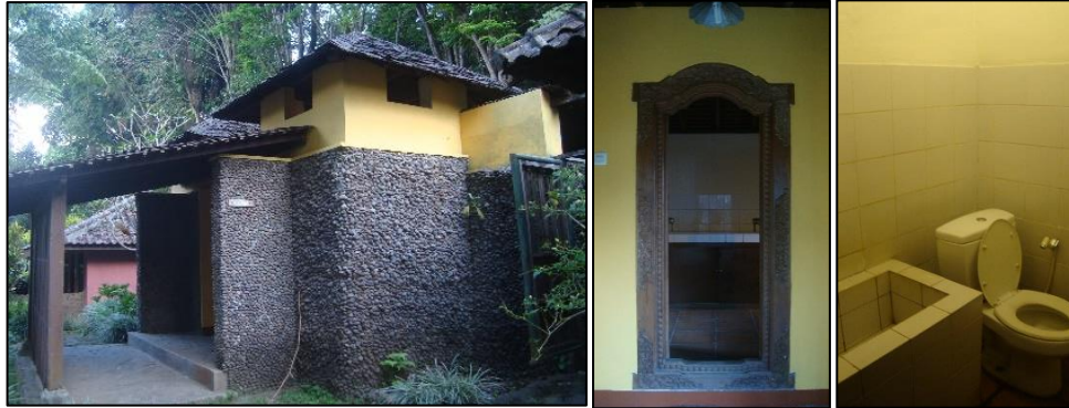
Gambar 4.25 Tampilan dan kondisi bangunan kamar mandi umum
