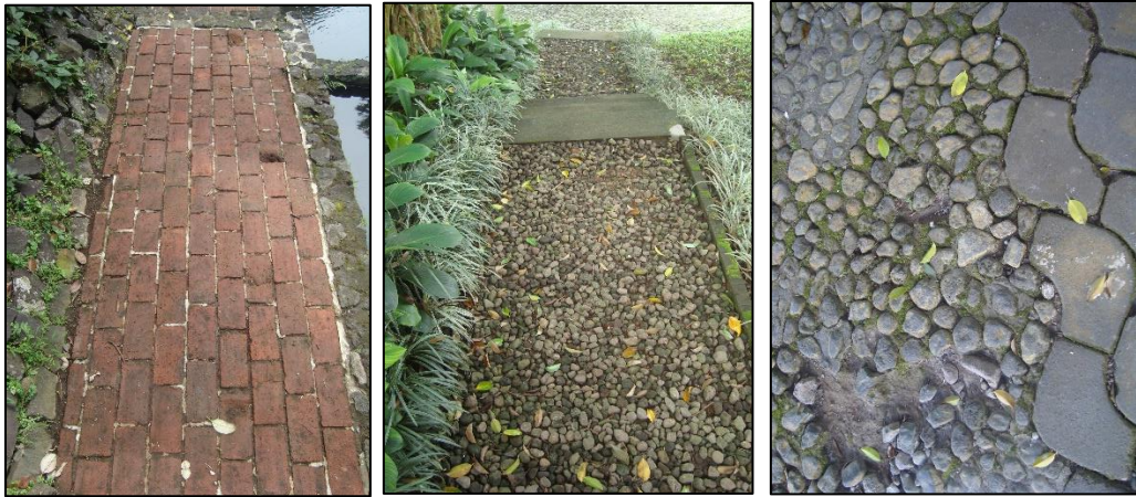
Gambar 4.45 Material penutup sirkulasi pejalan kaki
