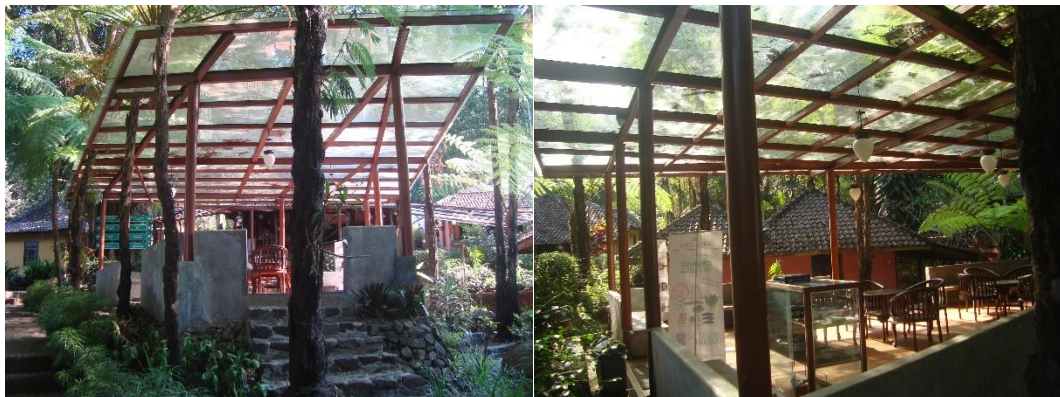
Gambar 4.94 Tampilan bangunan ruang tunggu
