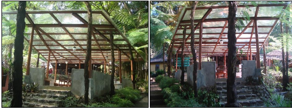
Gambar 4.32 Tampilan bangunan ruang tunggu
