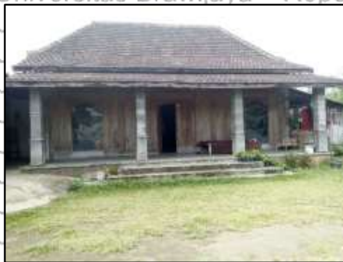
Gambar 4. 16 Bangunan khas Desa Poncokusumo
