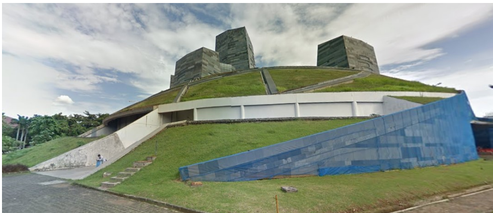
Gambar 4.26 Tampak utara perpustakaan
