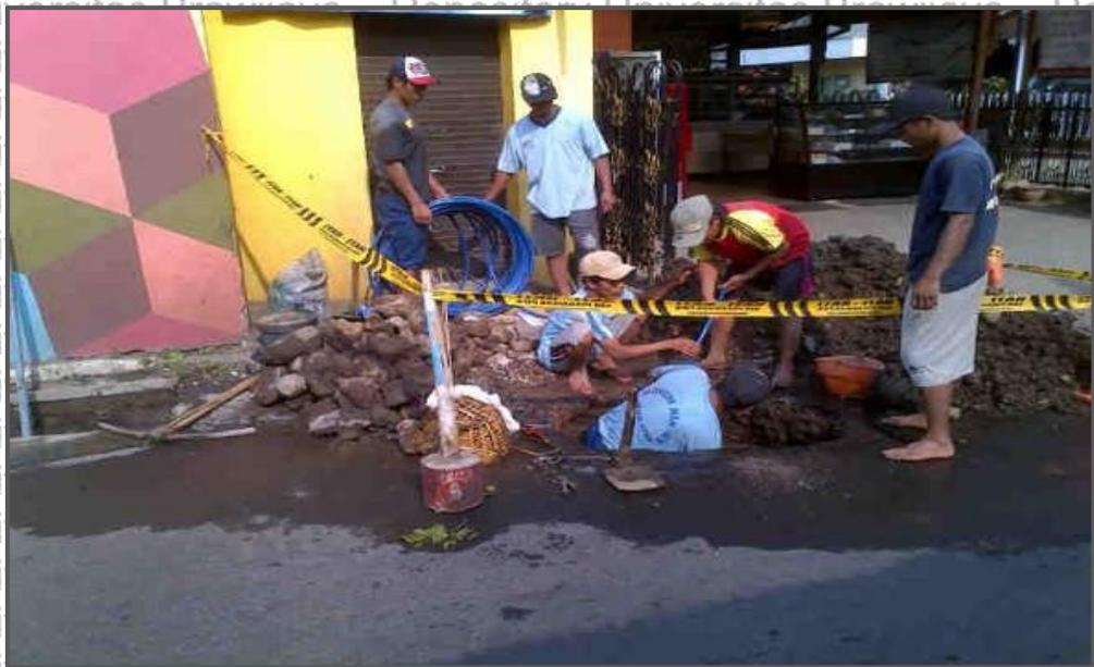
**Gambar.4.13 Kegiatan perbaikan pipa**
