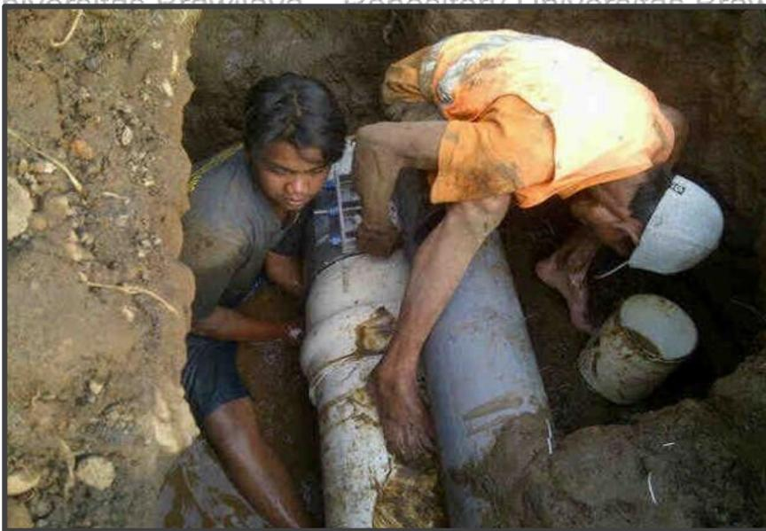
**Gambar.4.14 Kegiatan perbaikan pipa**
