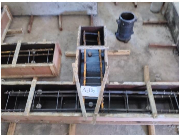
Gambar 4. 7. Bekisting dan Peletakan Tulangan yang Siap Cor
