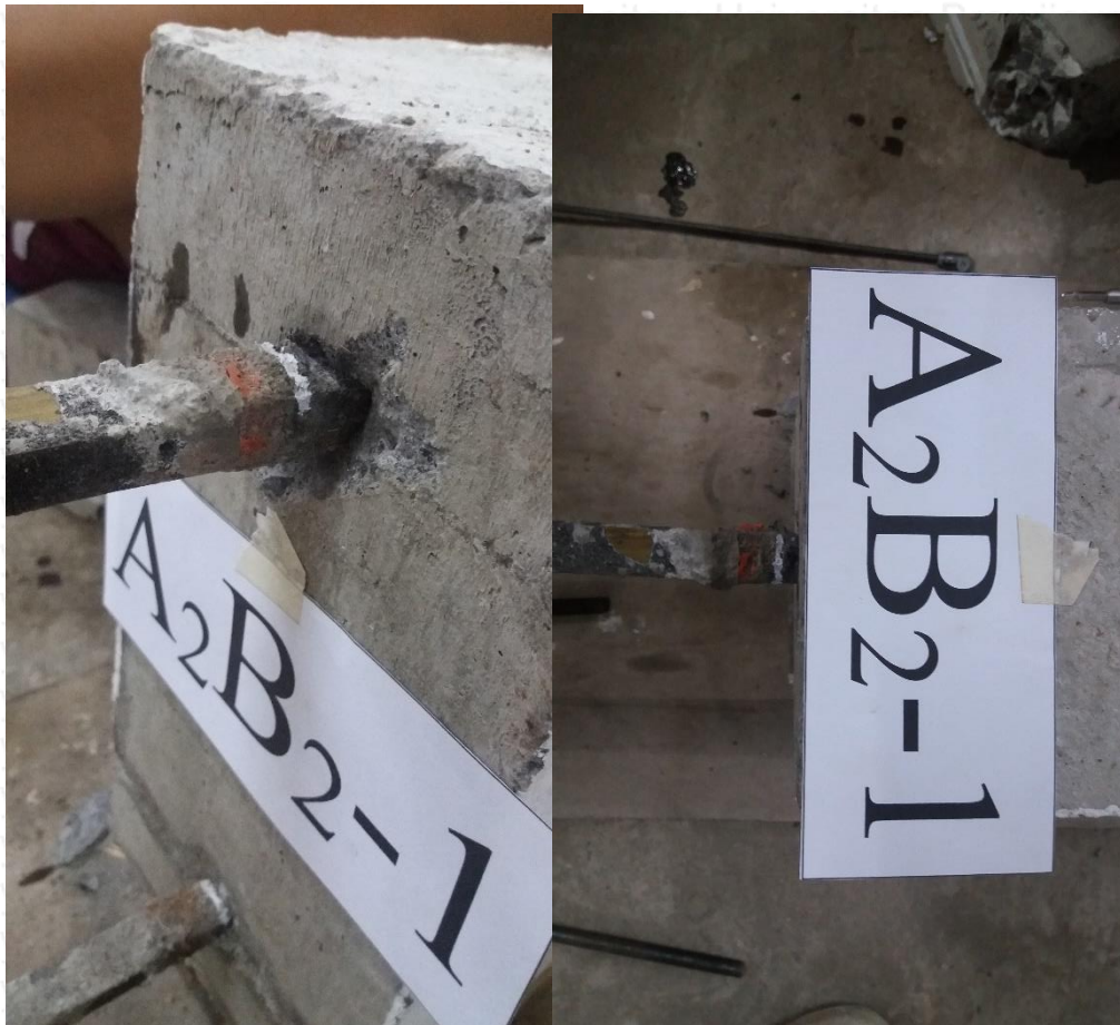
Gambar Keruntuhan Benda Uji Pull Out A 2 B 2 - 1
