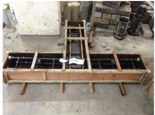
Gambar 4. 7. Bekisting dan Peletakan Tulangan yang Siap Cor
