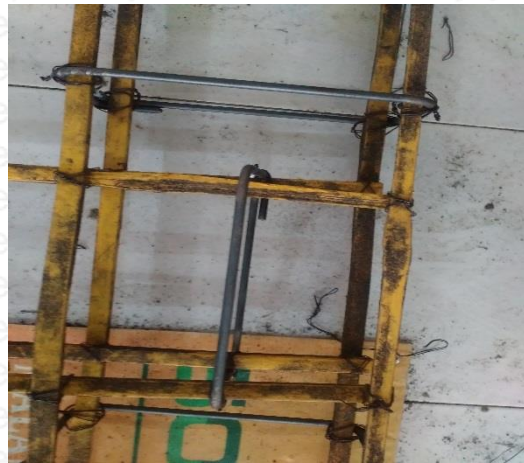
Gambar 4. 2. Penulangan Sambungan Balok-Kolom A 1 B 1
