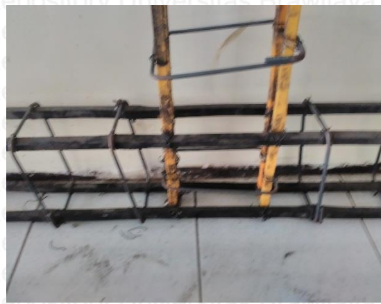
Gambar 4. 3. Penulangan Sambungan Balok-Kolom A 1 B 2
