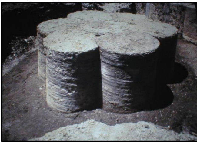
Gambar 2.10 Hasil Kolom Stabilisasi DSM
