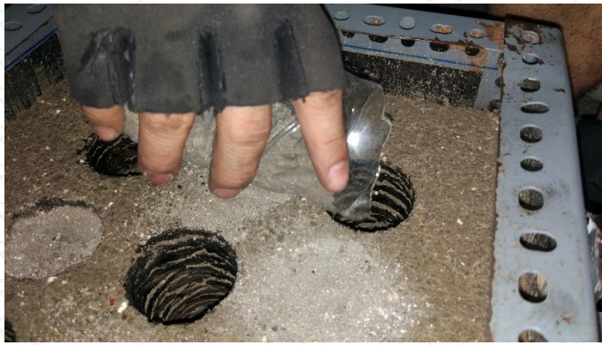
Gambar Instalasi Kolom DSM (2)
