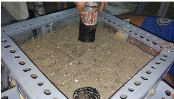
Gambar Instalasi Kolom DSM (1)
