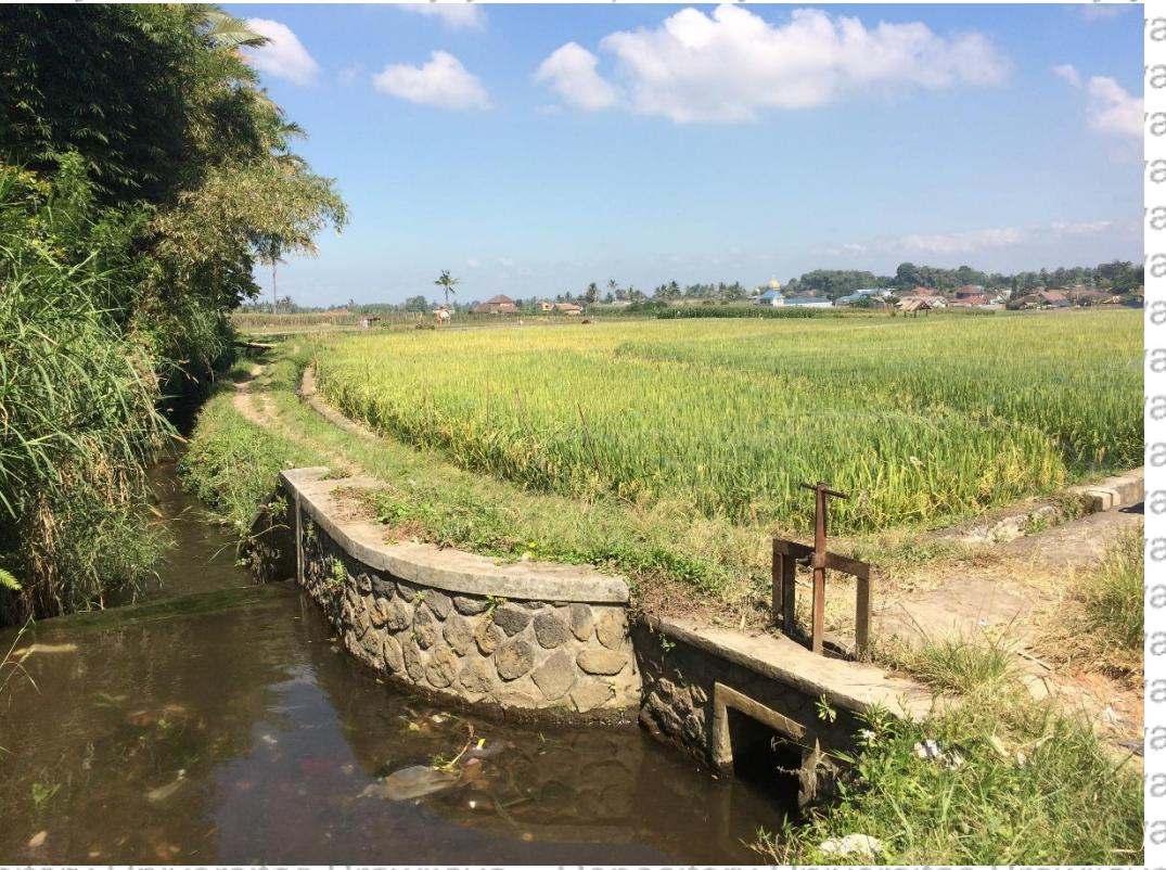
**Gambar 3.8.** Pintu pengambilan di petak tersier KA.1B Ki
