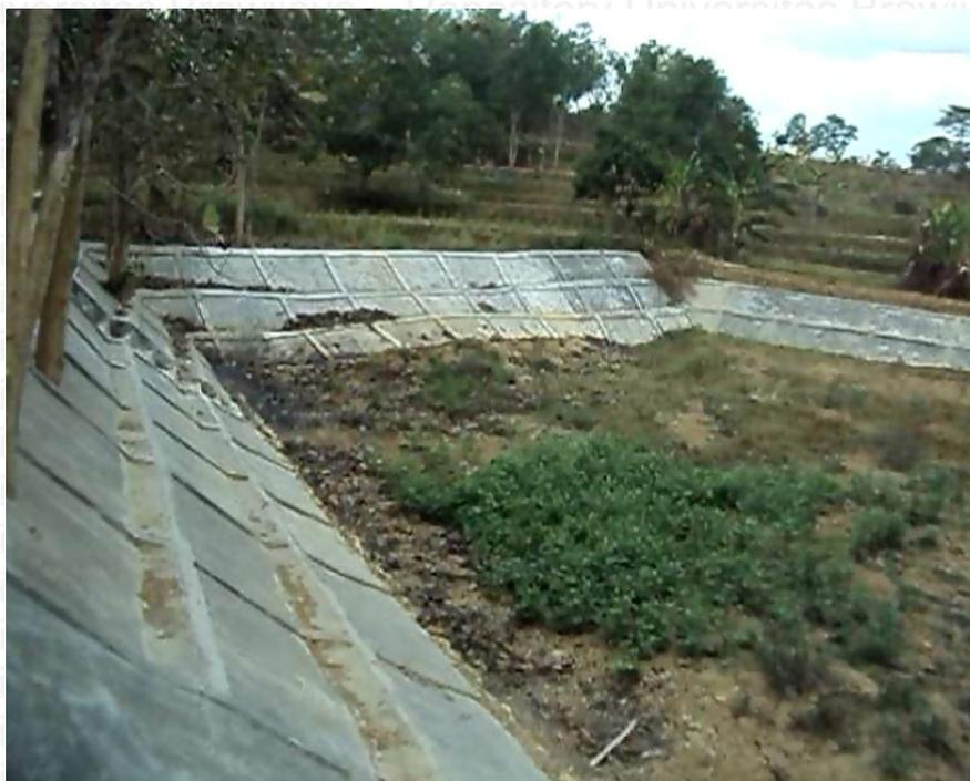
Gambar 4.12 Sedimentasi Pada Embung Sawah Tengah
