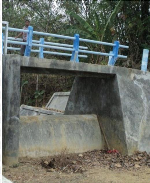
Gambar 4.15 Kondisi Eksisting *Spillway* Embung Sawah Tengah
