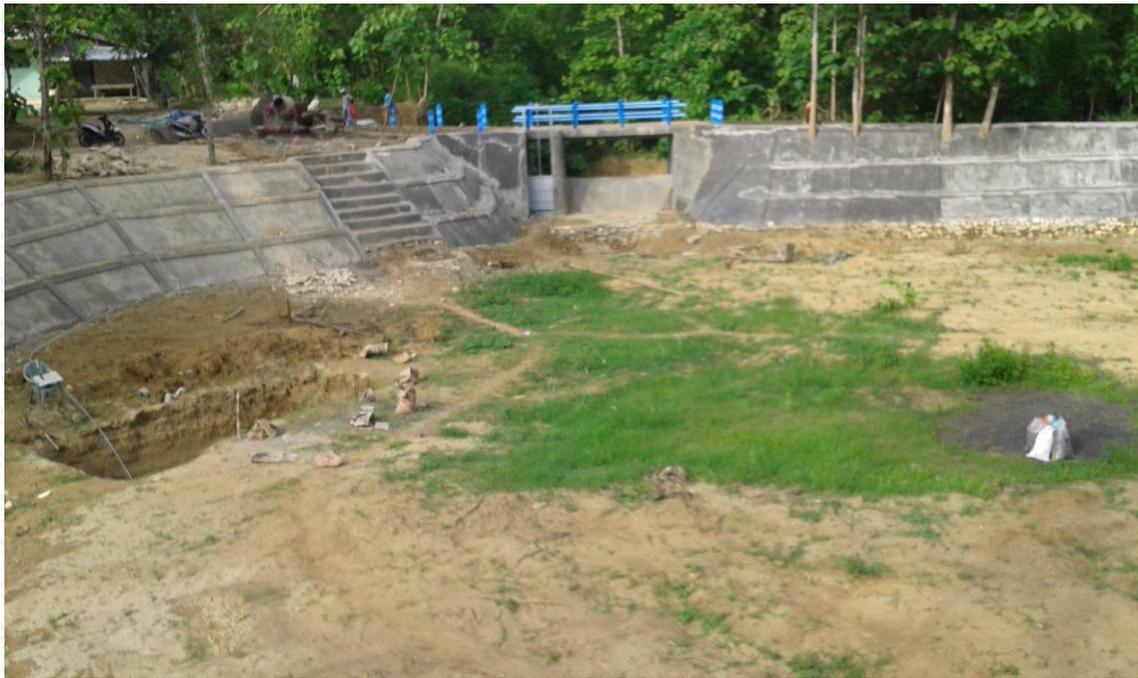
Gambar Jembatan dan Spillway pada Embung Sawah Tengah:
