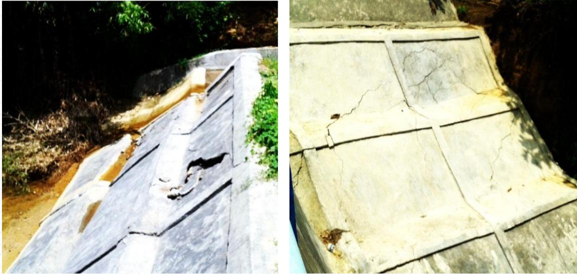
Gambar 4.13 Retakan Pada Dinding Embung Sawah Tengah
