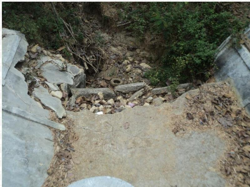
Gambar 4.11 Kerusakan Apron Depan *Spillway* Embung Sawah Tengah
