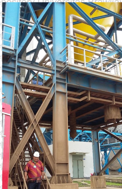
Silo Penampungan Fly Ash
