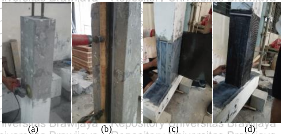
Gambar 4.9 (a) Prose penghalusan, (b) Prosen pemasangan CFRP plate (c) Pemasnagan CFRP sheet dan (d) Finishing
