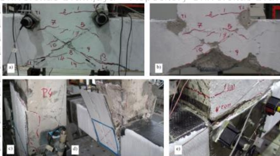
Gambar 2.15 Pola Kerusakan benda uji (a & b) benda uji control, (c & d) benda uji perkuatan FRP dan (e) perkuatan dengan plat baja
