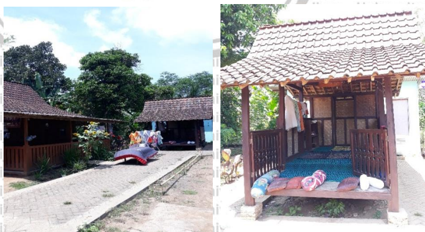
Gambar 4.8 Kondisi Lingkungan di Cagar Budaya Sukosari
