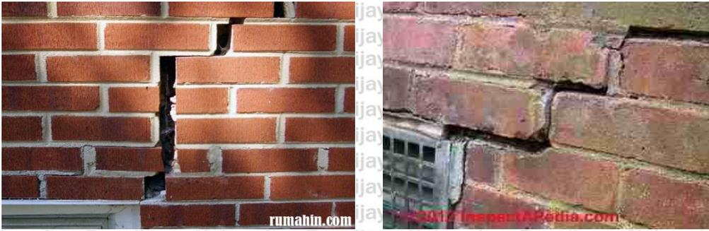
Gambar 1.1. Pola Kerusakan dinding diawali dengan kegagalan Mortar
