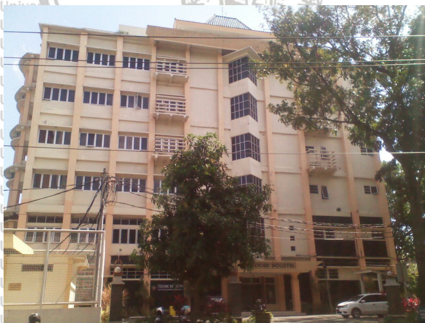
Gambar 4.3 Gedung Teknik Industri Fakultas Teknik Universitas Brawijaya Malang
