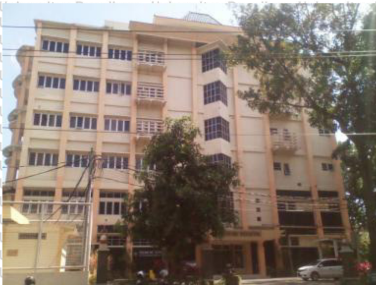
Gambar 5.2 Tampak depan gedung Teknik Industri Fakultas Teknik Universitas Brawijaya
