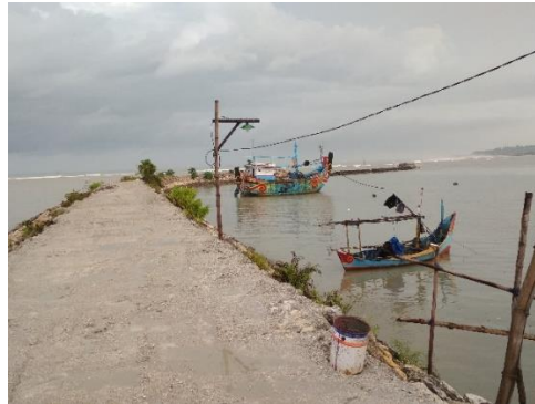
Gambar 19. Kondisi Brok Dowo setelah diperbaiki Sumber: Pribadi
