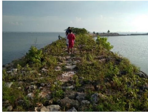
Gambar 12. Brok Dowo sebelum perbaikan jalan
