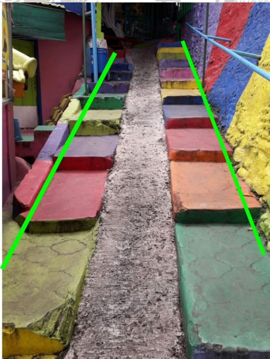
Gambar 4.46 Alternatif penyelesaian iluminasi sarana jalan keluar Zona B
