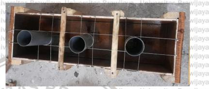
Gambar 4.1 Penyusunan Pipa pada Bekisting Balok
