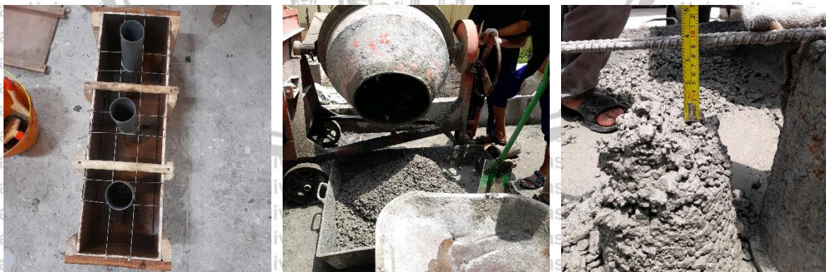
Gambar 4.1 Proses pembuatan benda uji (a) Persiapan bekisting; (b) Pengadukan campuran beton dengan concrete mixer ; (c) Pengujian Slump
