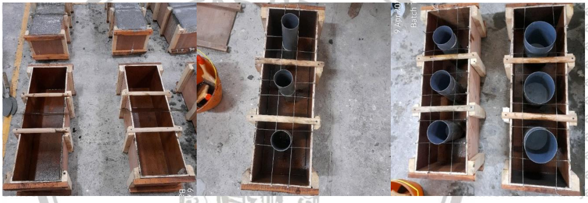
Gambar 2. Persiapan bekisting balok (mengolesi oli pada permukaan dalam)
