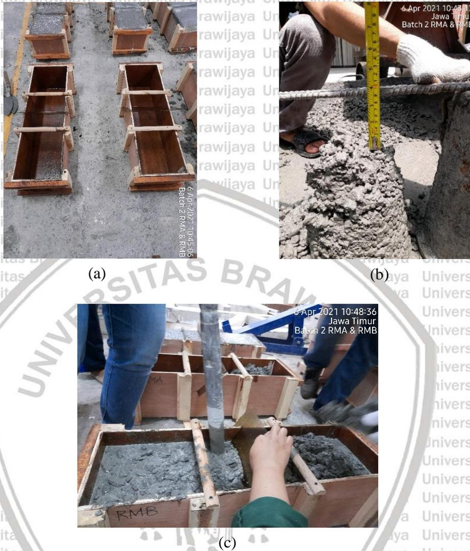
Gambar 4.1 Pembuatan benda uji. (a) Persiapan uji, (b) Pengujian nilai *slump* (c) Penuangan serta pepadatan beton dalam bekisting
