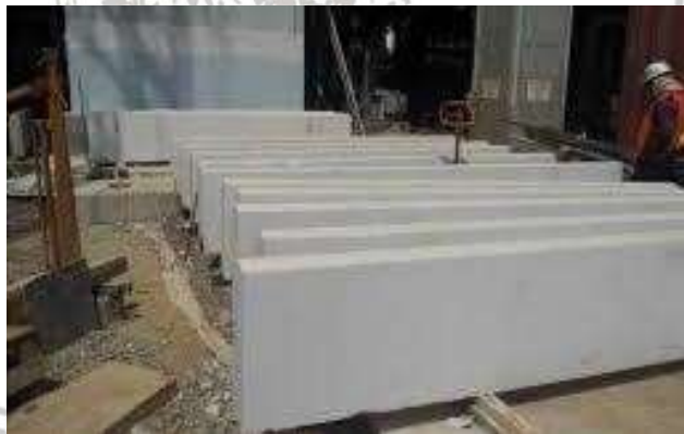
Gambar 2.1 Contoh Beton Pracetak
