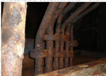
Gambar 2.2 Korosi seragam pada pipa ballast
