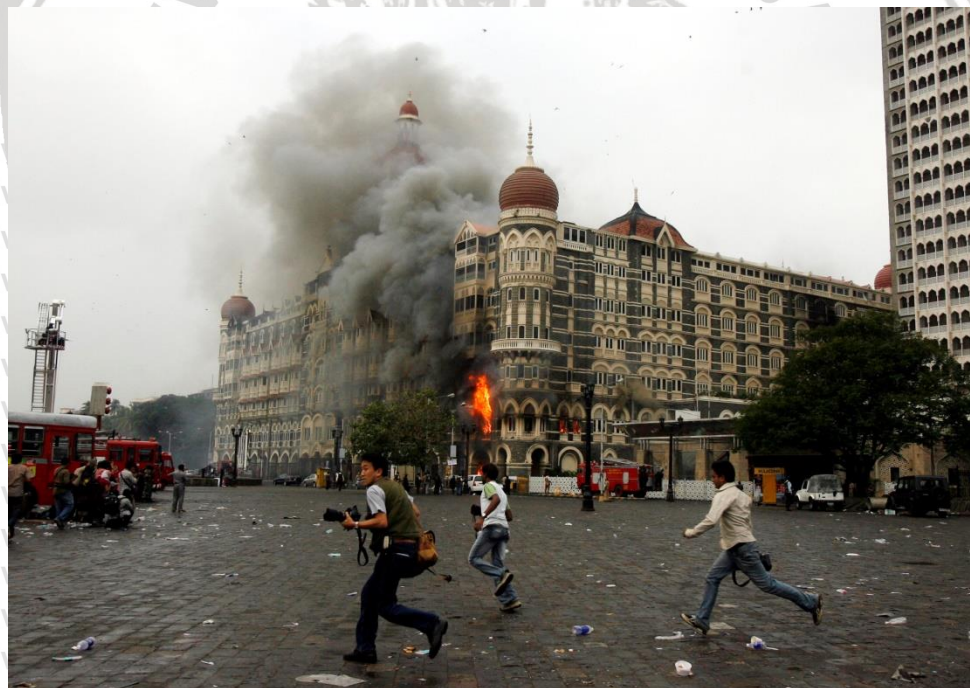
Gambar 4.3 Kerusakan bangunan pada serangan Mumbai 2008
