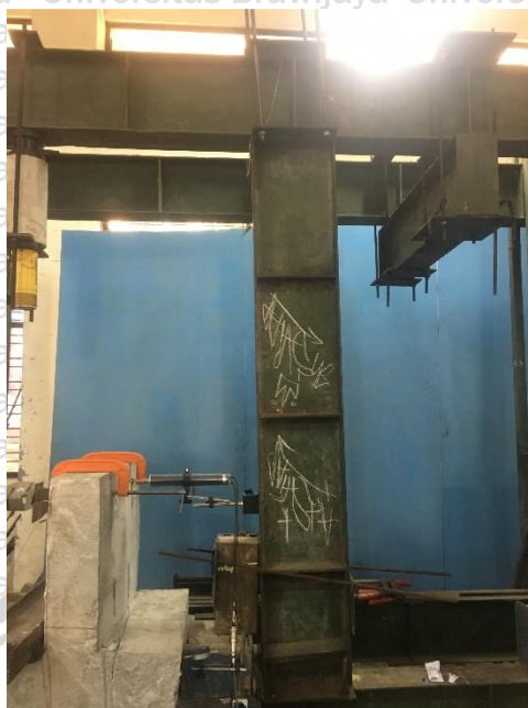
Gambar 4.4 Frame yang bengkok karena tidak mampu menahan gaya pada benda uji
