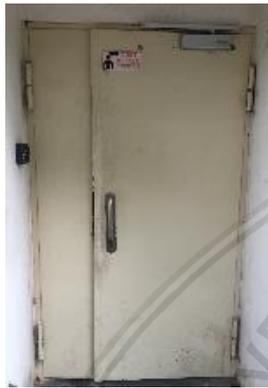
Pintu ini bermaterialkan logam dengan finishing cat berwarna putih dengan dua daun pintu yang berukuran 20 x 60 cm.
