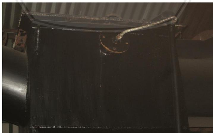
**Gambar 4.10. Waterscrubber pada cerobong asap insenerator**
