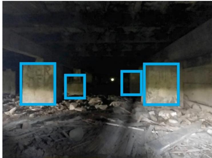
*Gambar 4. 29* Pondasi Umpak Beton pada zona I
