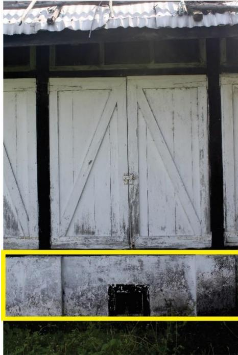
*Gambar 4. 45 Dinding Bata pada sisi Barat Bangunan*
