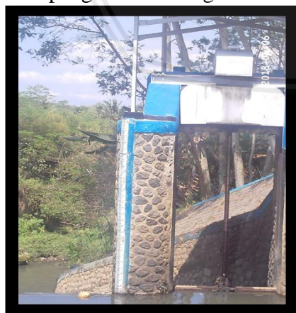
Gambar 2.12 Dokumentasi bangunan penguras bendung
