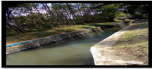
Gambar 2.13 Dokumentasi bangunan kantong lumpur
