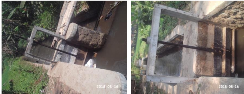
Gambar 2.25 Dokumentasi bangunan pengambilan 5
