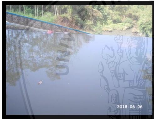
Gambar 2.5 Dokumentasi bangunan lantai bendung
