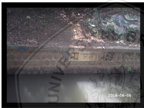
Gambar 2.14 Dokumentasi tampungan kantong
