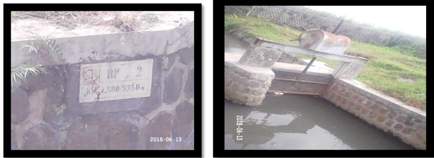
Gambar 2.22 Dokumentasi bangunan pengambilan 2
