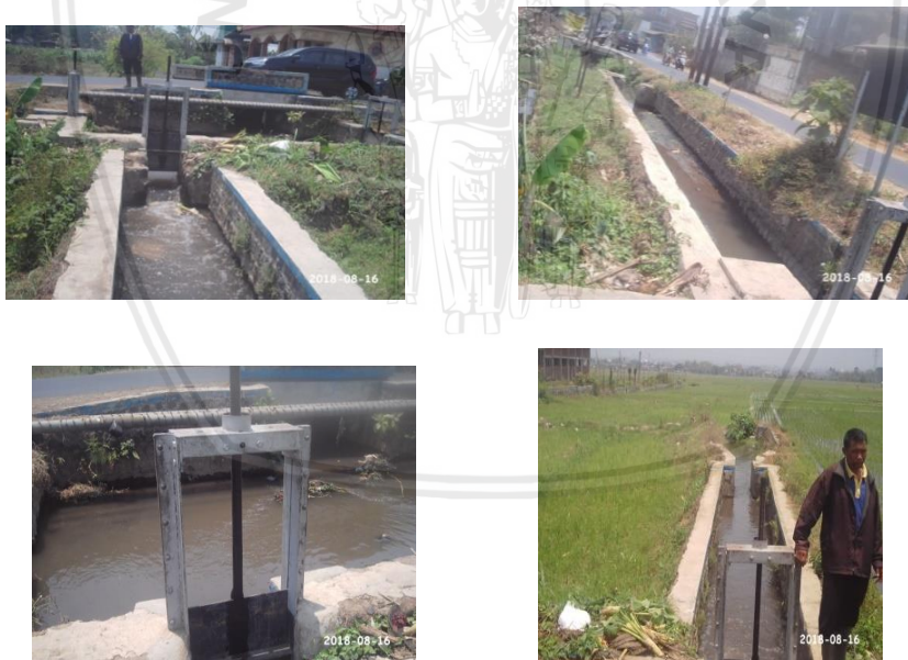
Gambar 2.26 Dokumentasi bangunan pengambilan 6
