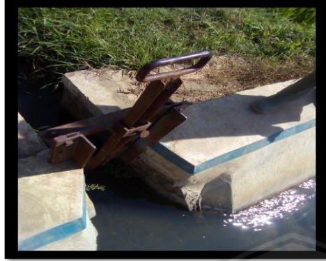
Gambar 2.19 Dokumentasi bangunan pengatur sadap pada saluran induk dan sekunder
