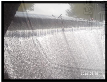
Gambar 2.3 Dokumentasi bangunan mercu bendung
