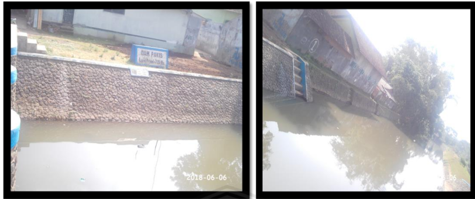
Gambar 2.4 Dokumentasi bangunan sayap bendung
