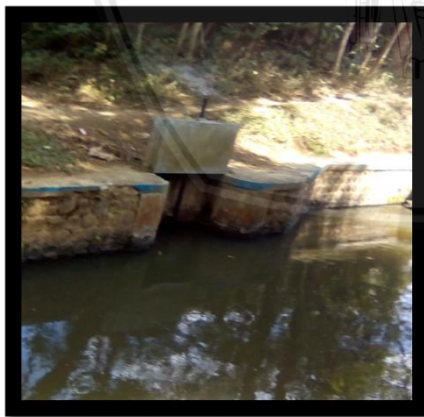
Gambar 2.15 Dokumentasi bangunan pintu penguras dan roda gigi kantong lumpur
