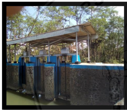
Gambar 2.11 Dokumentasi bangunan pengambilan ( intake )
