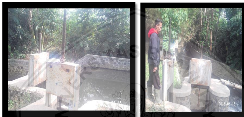
Gambar 2.23 Dokumentasi bangunan pengambilan 3
