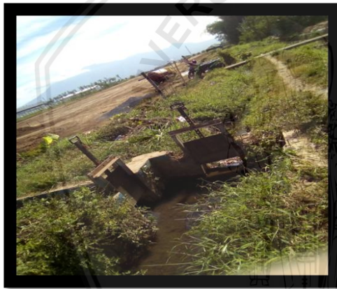
Gambar 2.20 Dokumentasi bangunan bagi sadap pada saluran tersier
