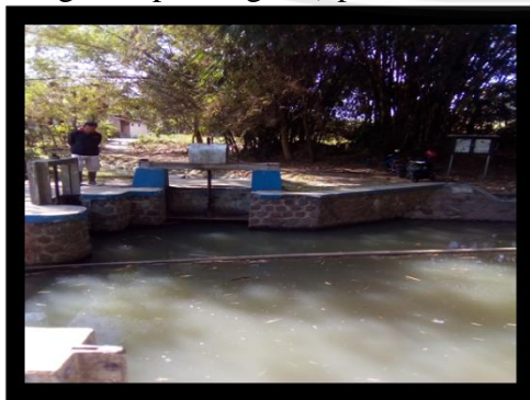
Gambar 2.21 Dokumentasi bangunan pengambilan 1 Pada bangunan pengambilan 1 peneliti tidak menemukan mistar ukur yang berfungsi mengukur debit air yang masuk pada bangunan air ini.
