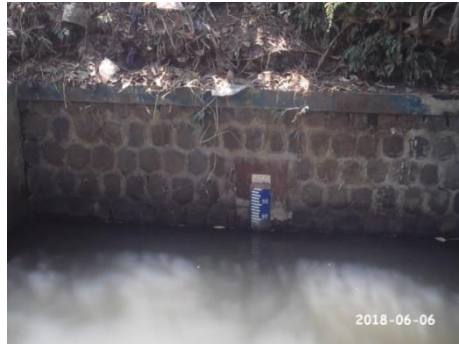
Gambar 2.27 Dokumentasi bangunan pengukur pada saluran kantong lumpur
