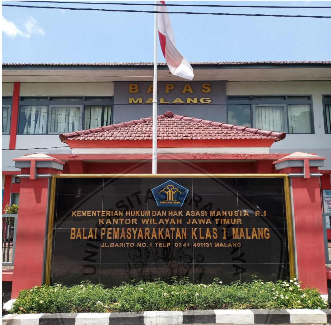
Tampak depan Kantor Balai Pemasarakatan Klas 1 Malang.
