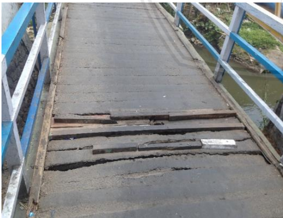
Gambar 1. 5 Kondisi lantai kendaraan dari bawah
