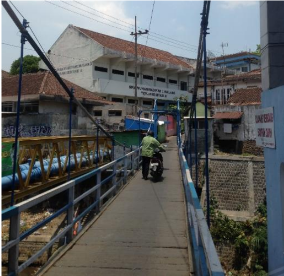
Gambar 1. 3 Kondisi utama ( main cable )
