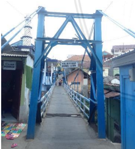
Gambar 1. 2 Menara ( pylon ) jembatan gantung
